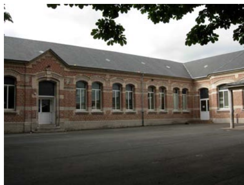
Cliché 168 (3 juillet 2008) Le décor soigné des façades sur cour
