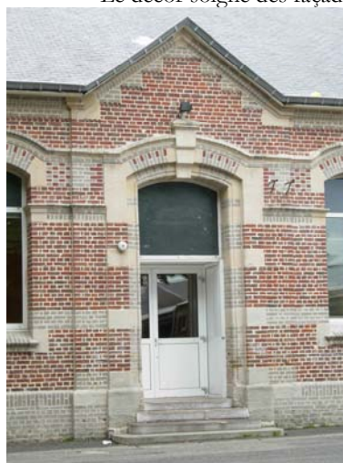
Cliché 175 (3 juillet 2008) Abaissement des portes lors de la rénovation
