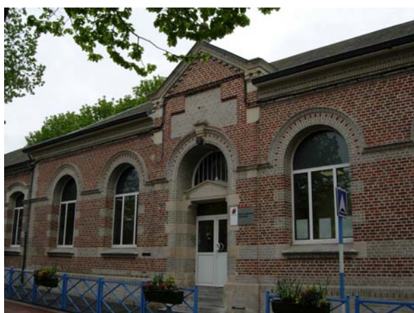
Cliché 32 (24 avril 2008) Le jeu des tons de briques sur les façades
