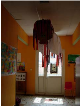
Cliché 96 (5 juin 2008) L'entrée de l'aile sur cour
