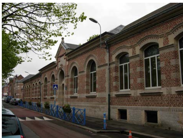
Cliché 33 (24 avril 2008) La façade sur rue et la contre-allée du boulevard
